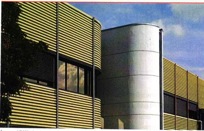
In nur 15 Werktagen sanierten die Malerwerkstätten Jaensch GmbH die Betonfassade.
