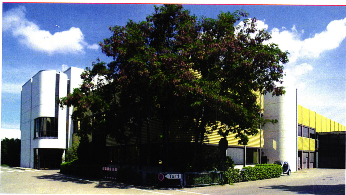
Rund 1000 m 2 Beton sanierte die Malerwerkstätten Jaensch GmbH.
