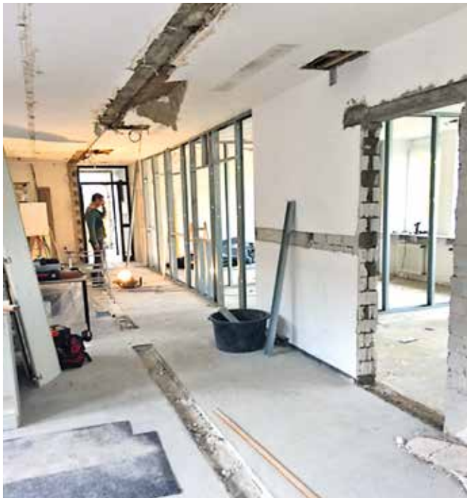
Umfangreiche Bauarbeiten: Wände wurden eingezogen und der Boden komplett erneuert.
