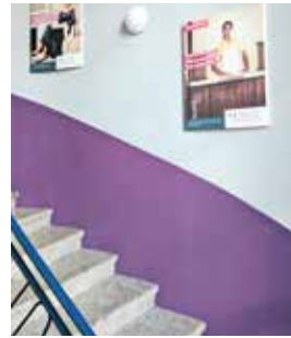
Abb.1: Nach VOB 2016 beinhaltet der farblich abgesetzte Treppenhausockel zwei besondere Positionen für farbiges Absetzen und Anpassen (Beschneiden).
