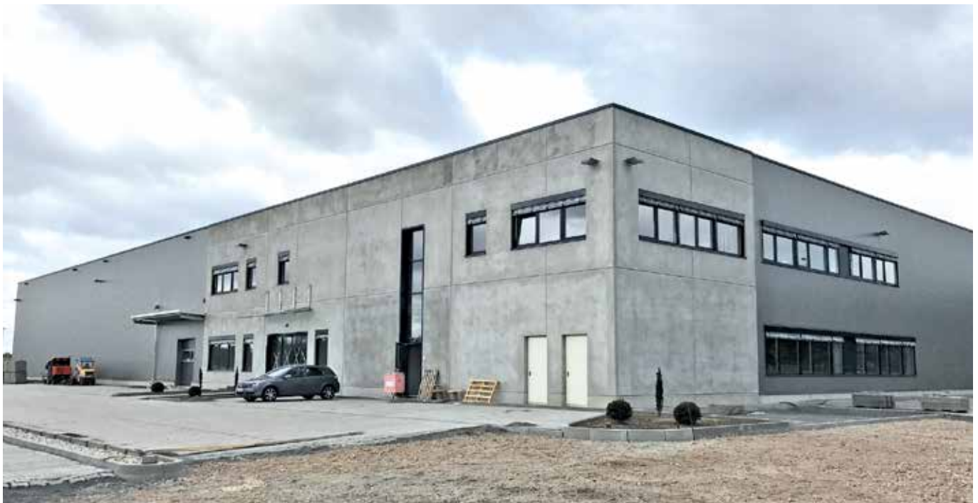
Der Neubau der MEGA Leipzig: 4.000 m 2 Platz für das komplette Vollsortiment der MEGA, fünf Mischmaschinen, geräumiges Wohnberatungszentrum sowie Büro- und Lagerflächen.
