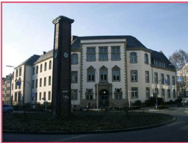
Das Amtsgericht in Mönchengladbach (nachher)
