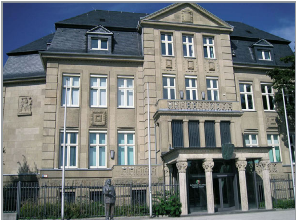
Das 1911 erstellte palastartige Gebäude im neoklassizistischen Stil diente bis 1998 als Staatskanzlei des nordrheinwestfälischen Ministerpräsidenten, wo die Firma Jaensch bei anstehenden Renovierungsarbeiten oft zum Einsatz kam. Bei der im Jahr 2007 durchgeführten Außensanierung wurden hier die gesamten Malerarbeiten von der Firma Jaensch ausgeführt.
